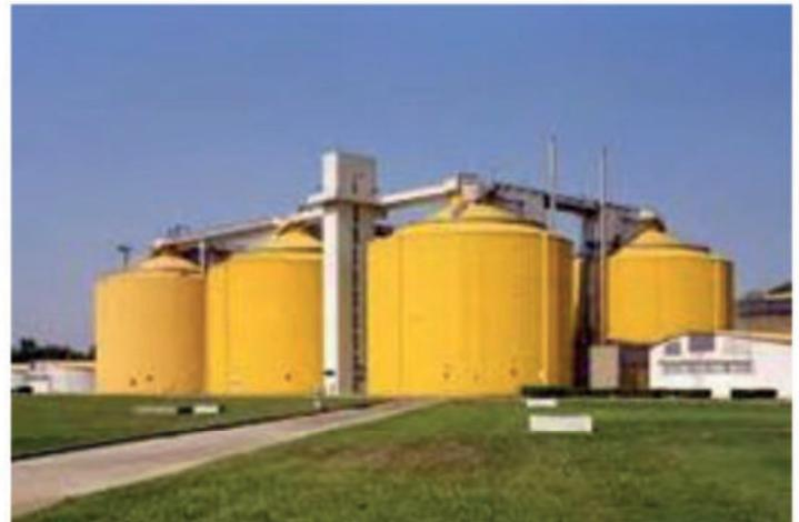
Nel corso di un precedente progetto di ricerca in collaborazione con il Politecnico di Torino, era stata messa a punto e sperimentata una tecnologia di pretrattamento termo-chimico a bassa temperatura dei fanghi biologici (di supero) a monte della digestione anaerobica, al fine di incrementarne la produzione di biogas, migliorare la disidratabilità dei fanghi e minimizzarne il quantitativo residuo.
