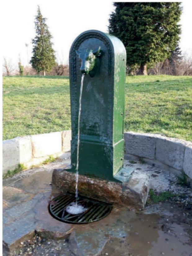
Attualmente lo scarico dei Toret è collegato alla fognatura con conseguente re-immissione dell'acqua nei corpi idrici. Il progetto prevede la realizzazione di una vasca di accumulo nei pressi del Toret, con capacità di circa 10 m<sup>3</sup>, all'interno della quale verranno convogliate le acque non utilizzate della fontanella. Il troppo pieno della vasca sarà collegato alla fognatura, ripristinando il ciclo idraulico del sistema.
